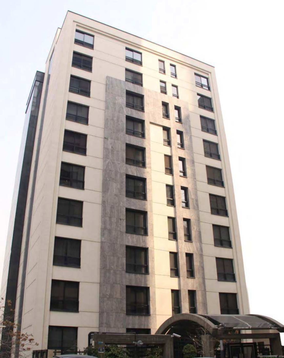
■ مجتمع مسکونی دیپلمات، الهیه گلنار | تهران
