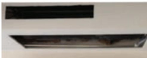
اجرای سقف کاذب با سینی بلند و نامتناسب بودن دریچه های دسترسی و دهش دستگاه
