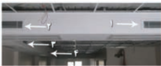
استفاده از ۴ دستگاه فن کویل در ۷۰ متر مربع فضا
