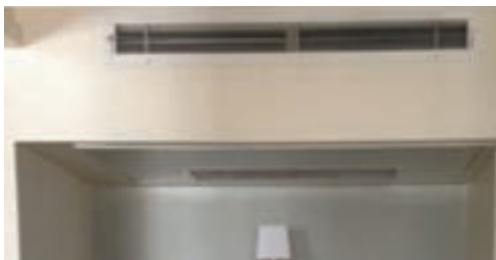
نصب فن کویل در سقف کاذب با محدودیت فضا و یکسان شدن طول دریچه های دهش و مکش
